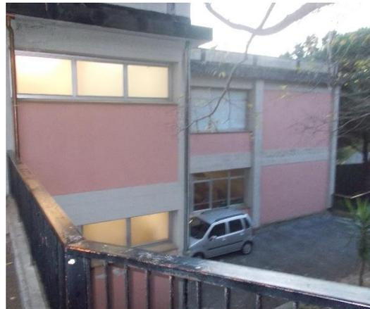
Il profilo termico della struttura è dovuto in gran parte alla sua morfologia: pareti e copertura non isolate, serramenti poco performanti.
